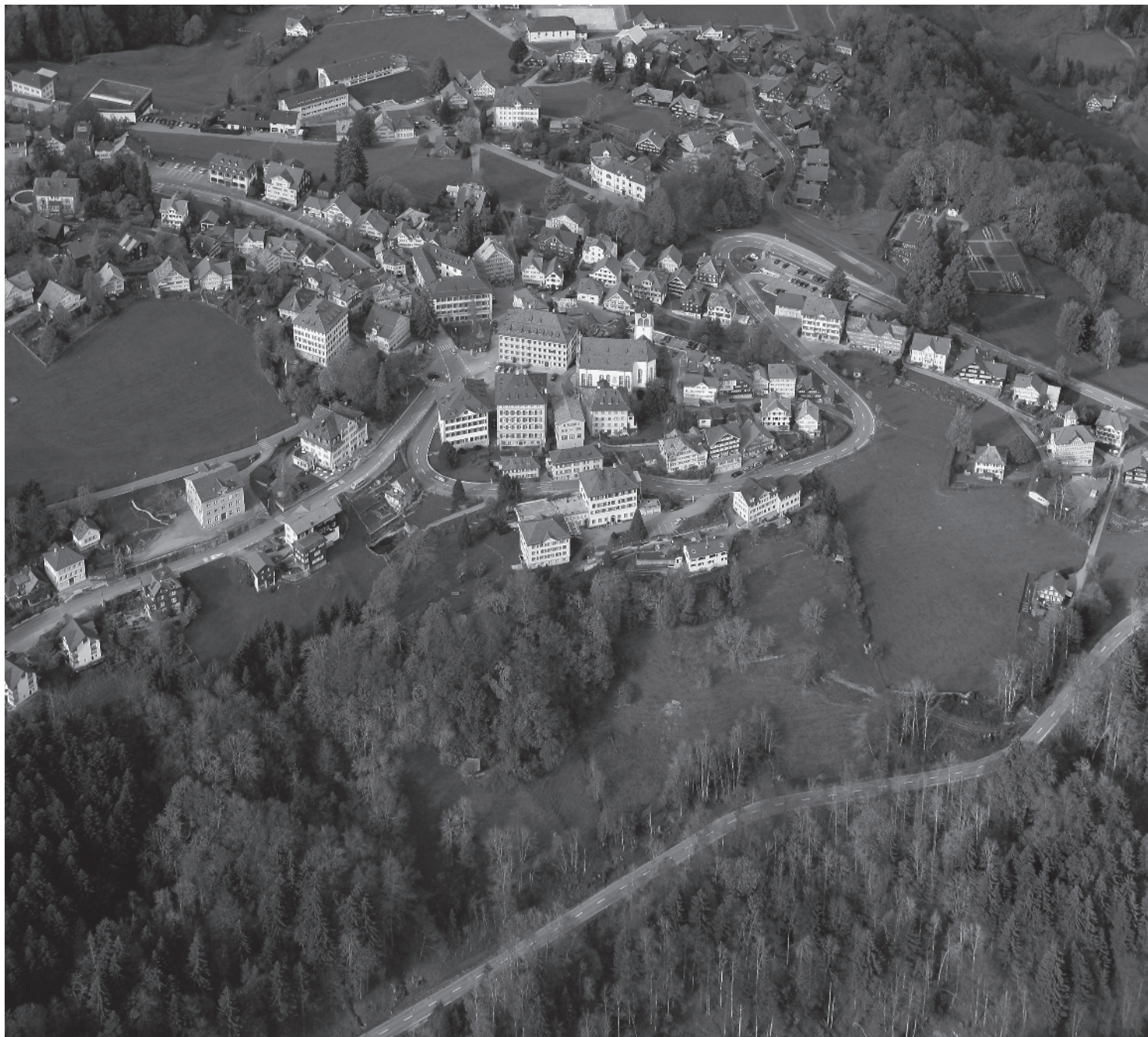
Flugbild Bruno Pellandini 2007, © Kantonale Denkmalpflege Appenzell Ausserrhoden
