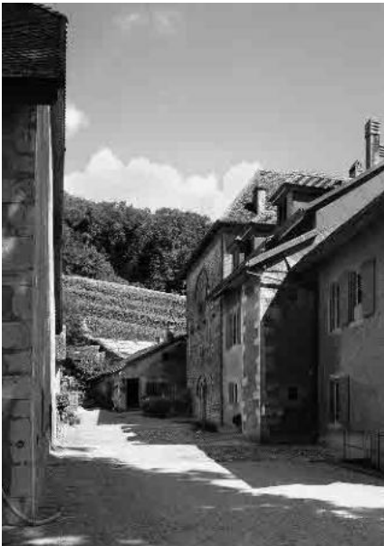
5 Entrée de l'ancienne église
