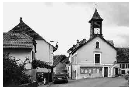
4 Maison de commune, ancienne école
