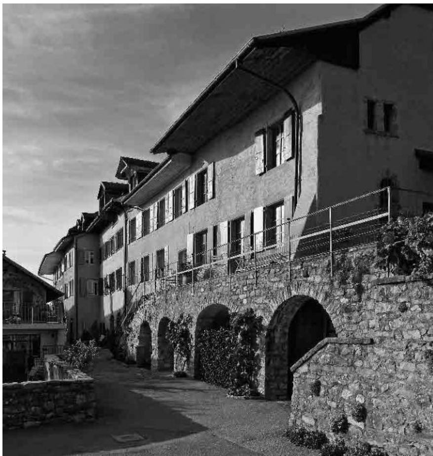
11 Rangée de maisons vigneronnes au lieu-dit Lallex
