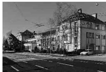
37 Usine de pompage des eaux
