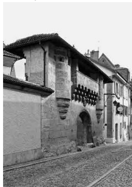
5 Portail d'entrée du château
