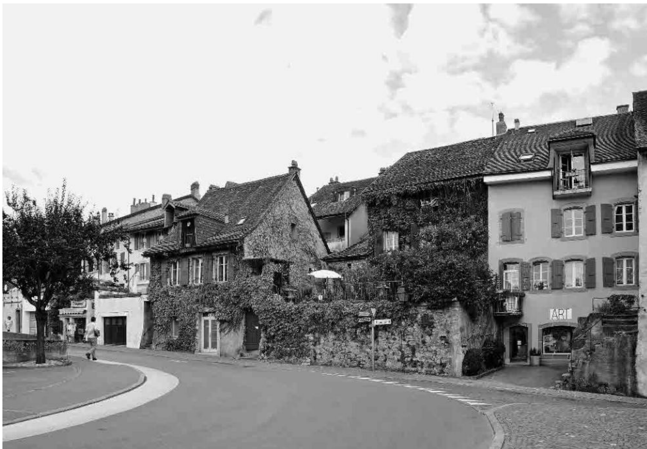
11 Rue des Terreaux, mur de braie du rempart
