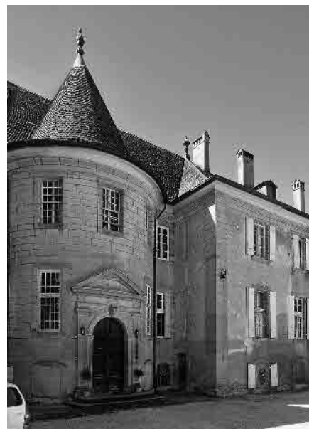
4 Entrée du château, côté cour
