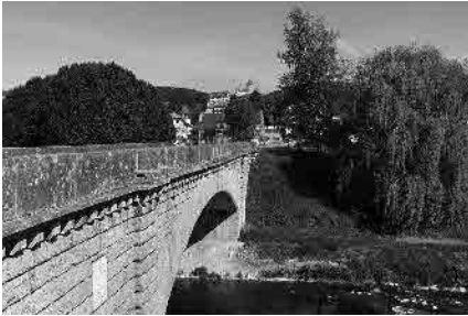
42 Pont sur la Broye
