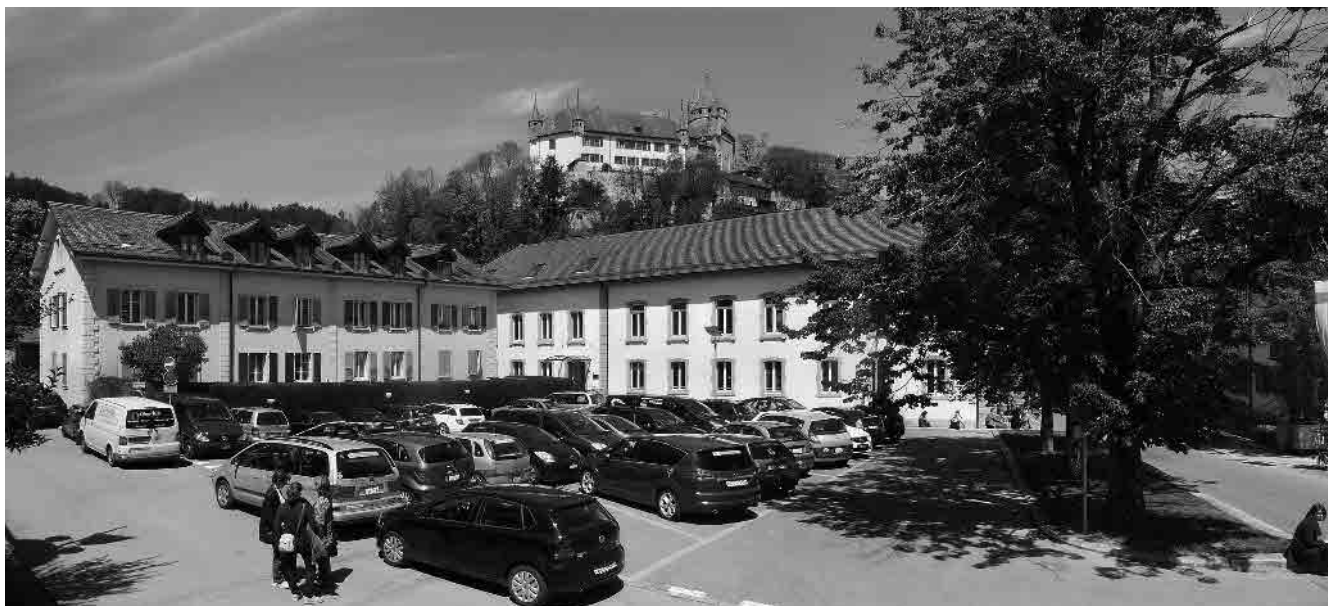
18 Logement ouvrier et anc. « salle de récréation », 1888–90
