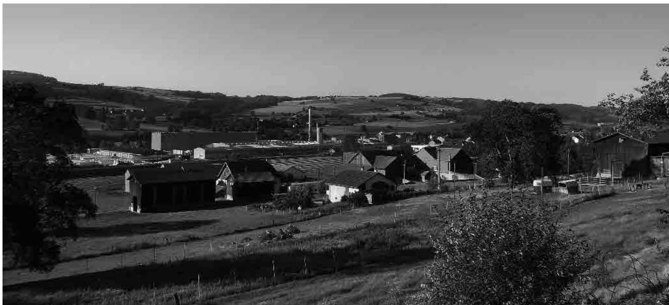
1 Cellule agricole et complexe industriel ISOVER
