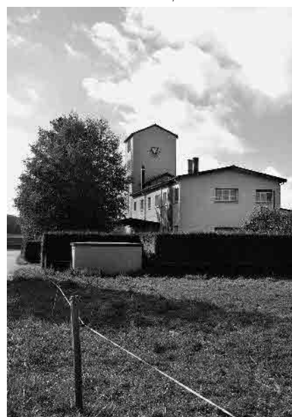
12 Anc. moulin industriel, 1958
