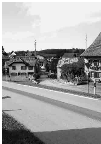
15 Rue du Petit-Bâle
