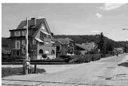
25 Route de la Gare
