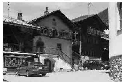
6 Façade plaquée en maçonnerie
