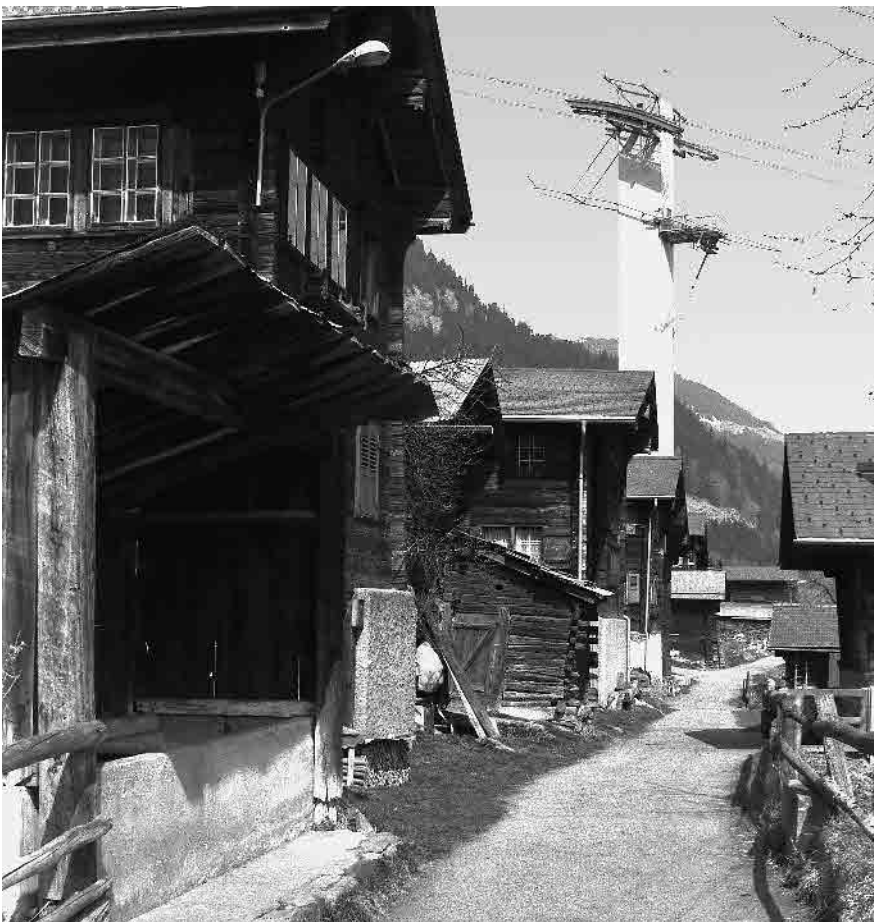
3 Hauptgasse und Mast Luftseilbahn
