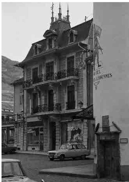
4 Immeuble Couchepin, vers 1910
