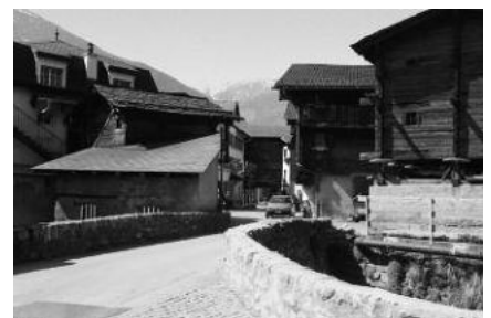
16 Steinbrücke über dem Kelchbach
