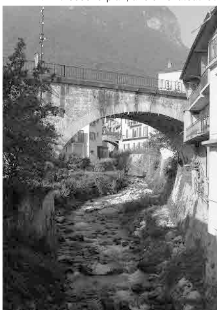
21 Pont sur la Morge
