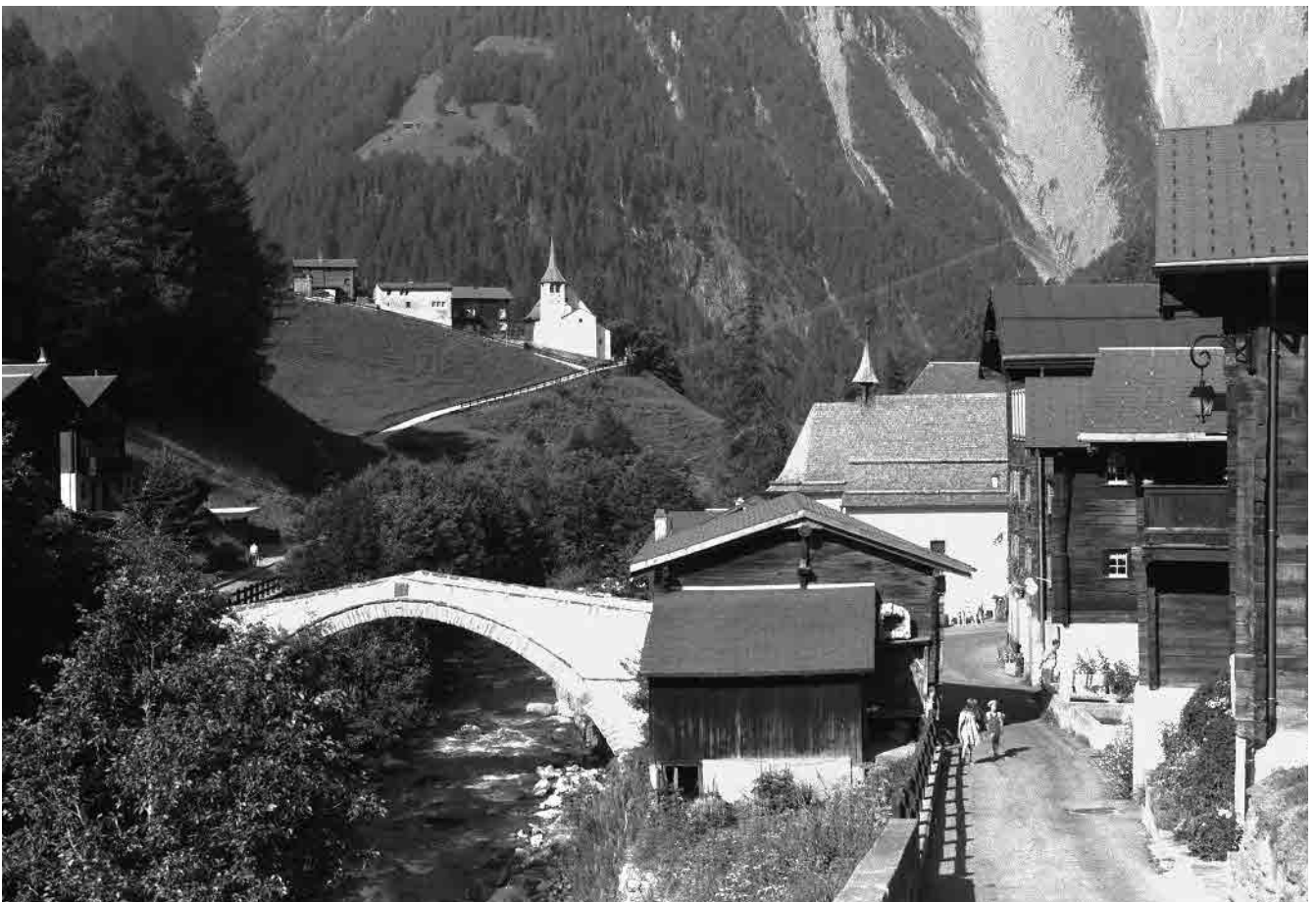
6 Steinerne Bogenbrücke, dat. 1564
