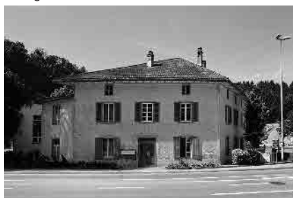
16 Ehem. Mühle, 19. Jh.
