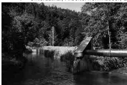
8 Aabach mit Wehranlage
