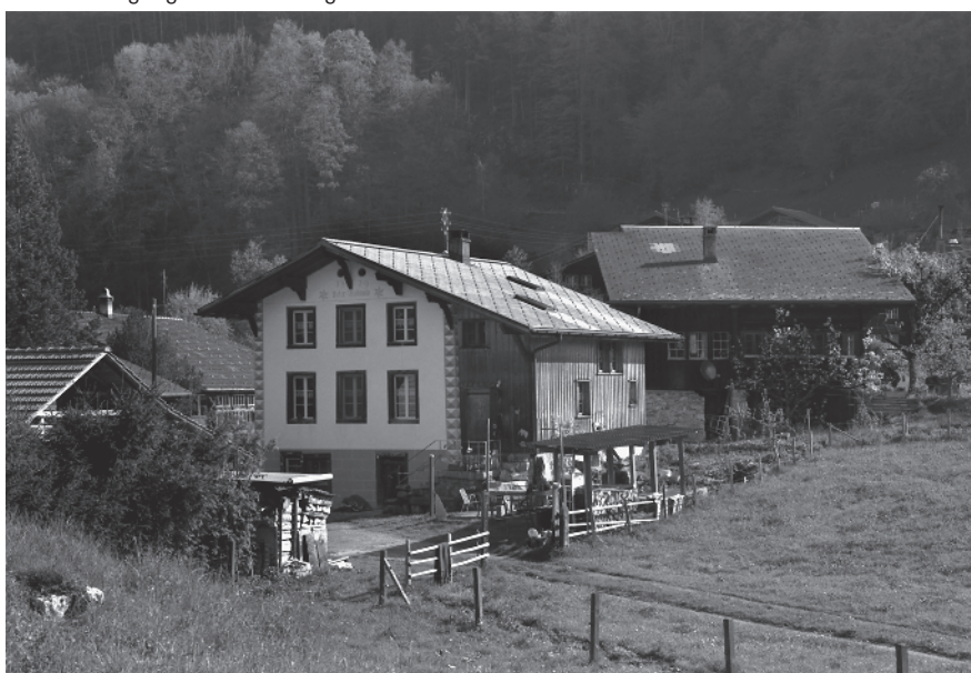
3 Ehemaliges Schulhaus, vermutlich von 1829
