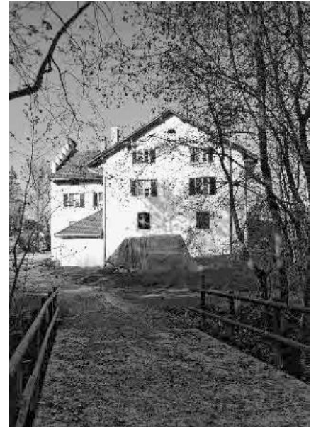
9 Ehem. Mühle, erwähnt 1361
