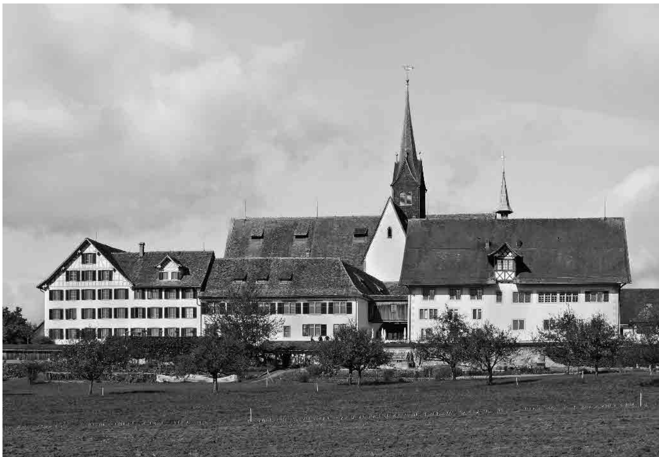
1 Ehem. Klosteranlage: gotische Kirche, Konventgebäude und ehem. Abtei
