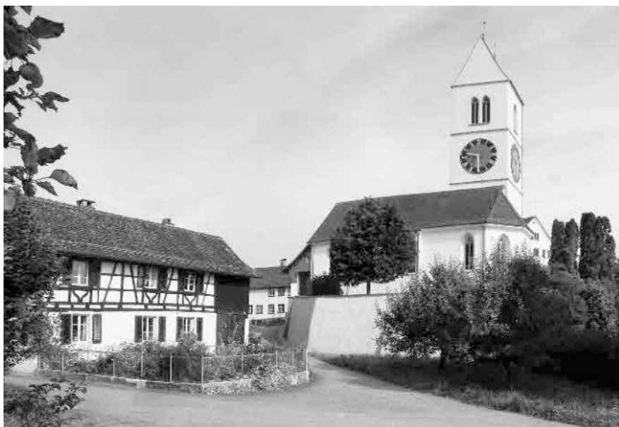
2 Pfarrkirche, 1511–16, und ehem. Schmiede, im Kern 18. Jh.
