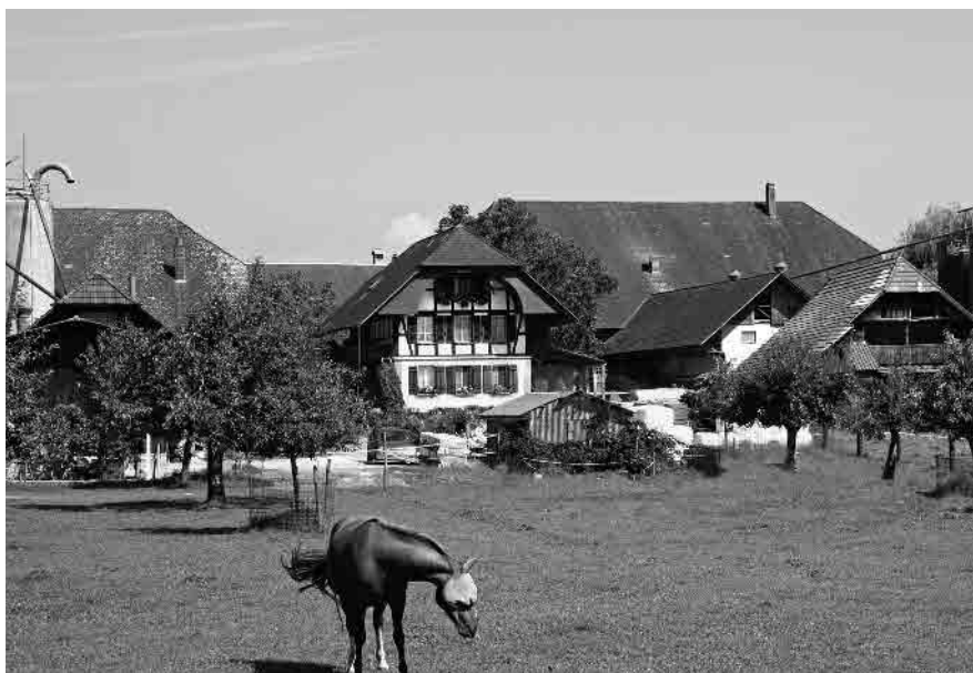
16 Südlicher Bebauungsrand, Riegstöckli, 1845, und Speicher, 1707
