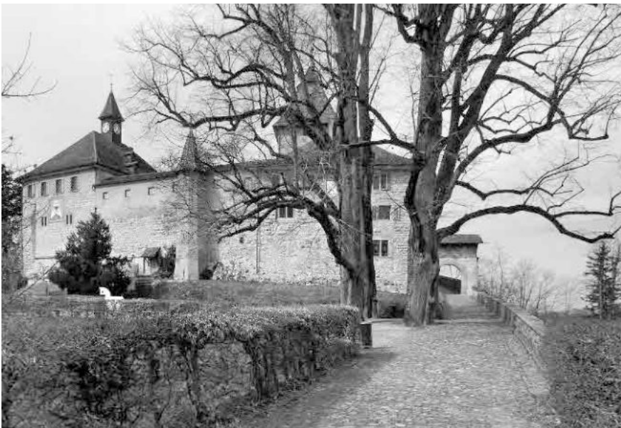
10 Burganlage, E. 12./A. 13. Jh.
