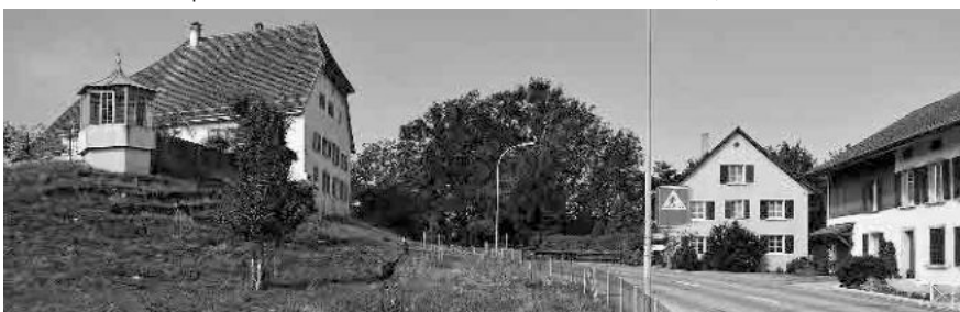
17 Stalden, Wohnhaus «Zur Stube», 1511
