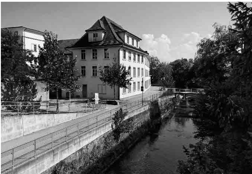
32 Ehem. Kardenfabrik an der Jona
