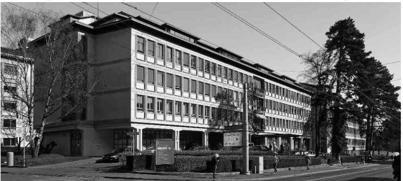
4 Hauptgebäude des Universitätsspitals Zürich, 1942–53
