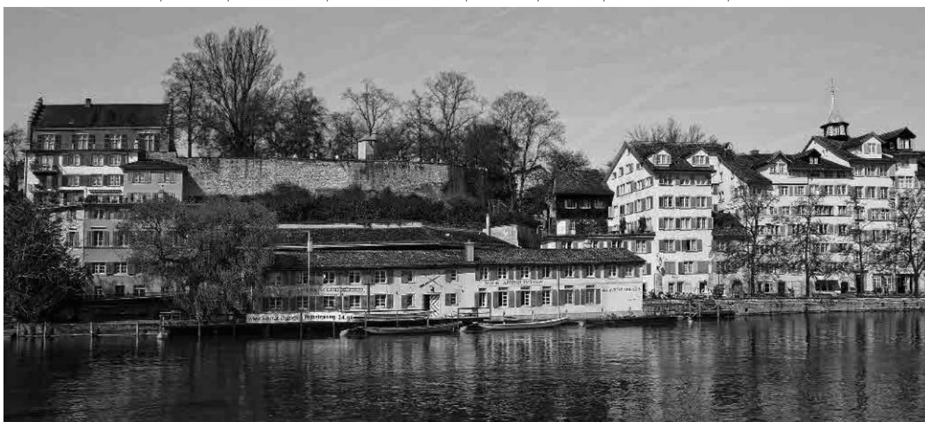
6 Linksufrige Altstadt, Schipfe und Lindenhof mit Resten der Kastellmauer, Freimaurerloge, 1852–54
