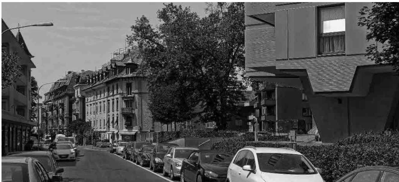
9 Gubelstrasse, Mehrfamilienhäuser, um 1900, im Vordergrund Überbauung Zum Bauhof, 1962–67
