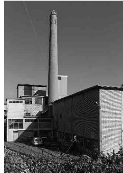
18 Ehem. Maschinenfabrik Oerlikon
