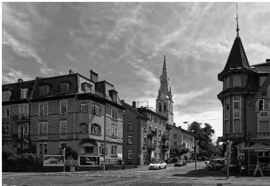
7 Schwamendingenstrasse, kath. Kirche Herz-Jesu, 1891/92, Turm von 1907
