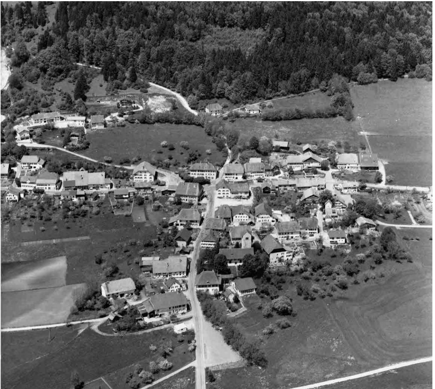
Photo aérienne 1972, © AFMH, Berne
