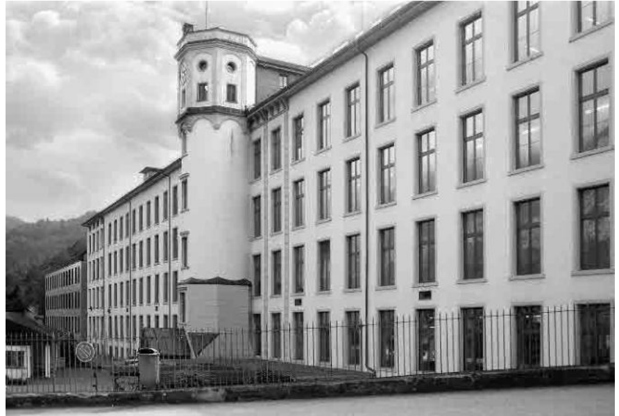
18 Hauptgebäude der Spinnerei mit Trepenturm
