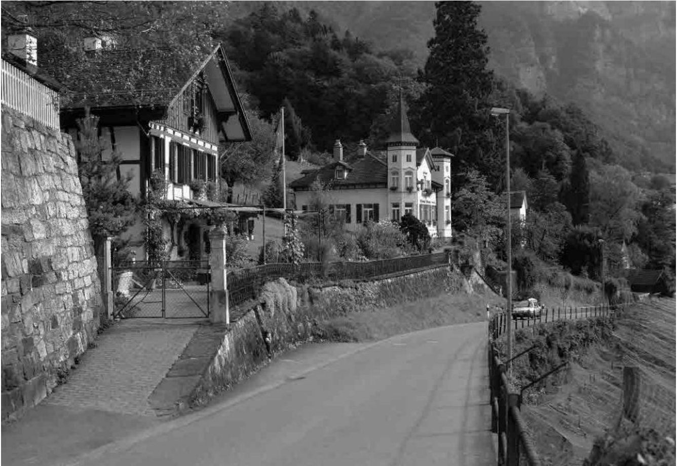
35 An der Bergstrasse
