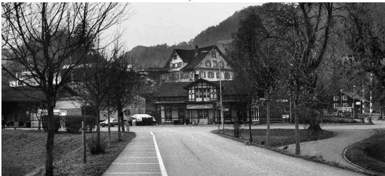
40 Altes Aufnahmegebäude von 1870
