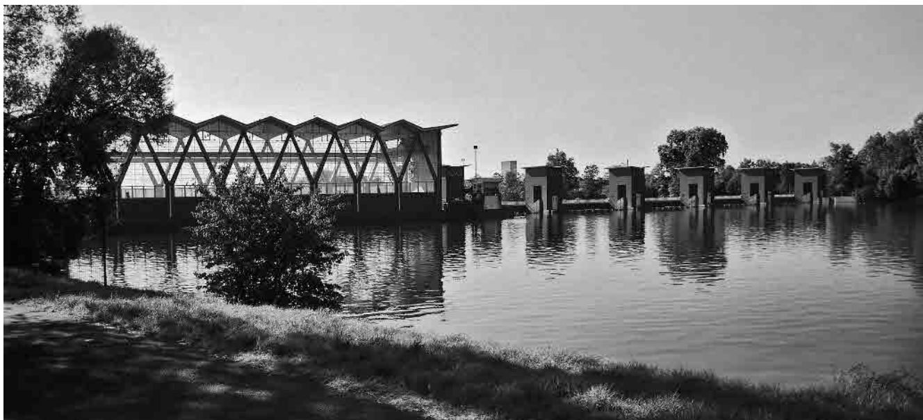
1 Maschinenhaus und Stauwehr
