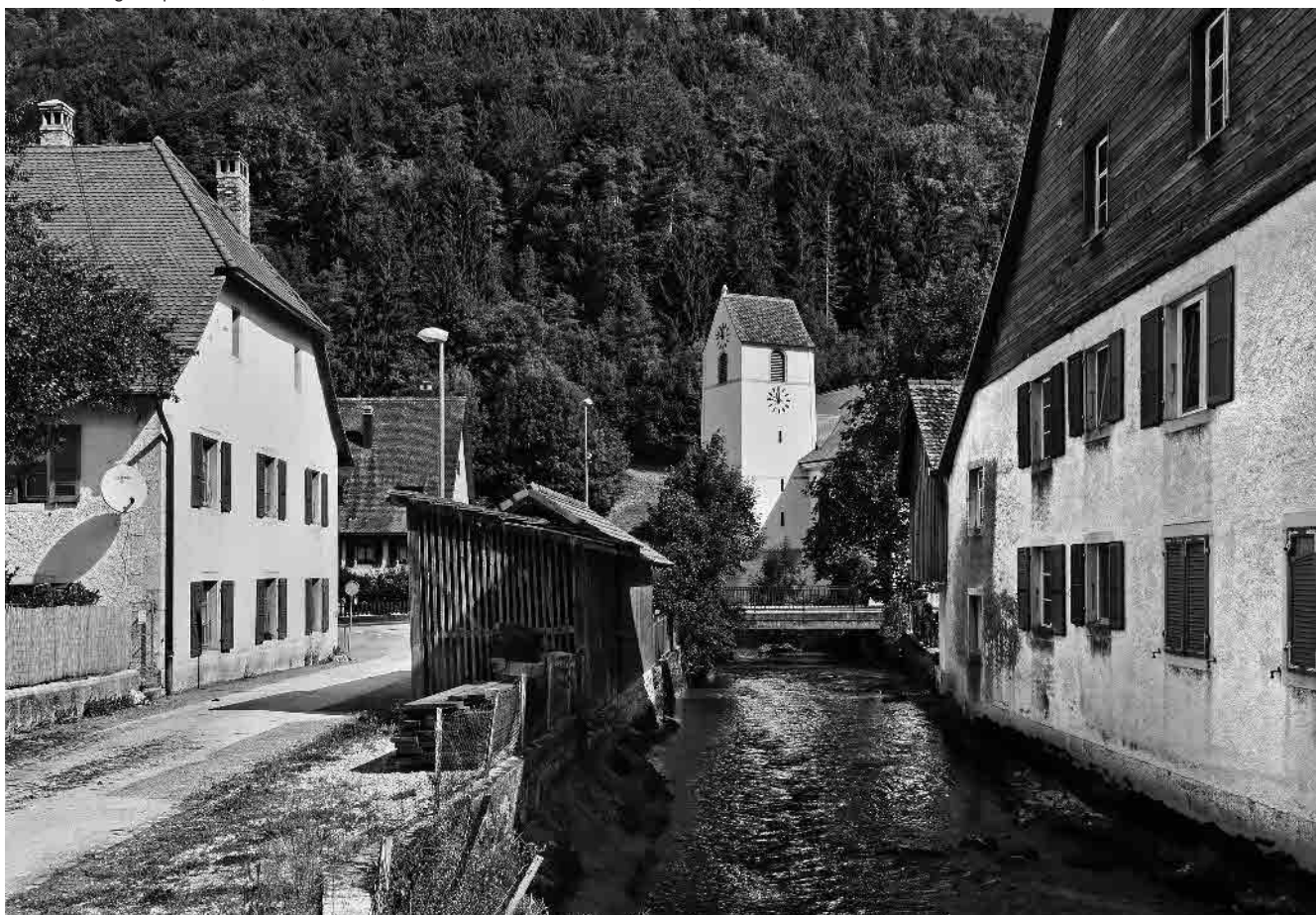
12 La Sorne canalisée
