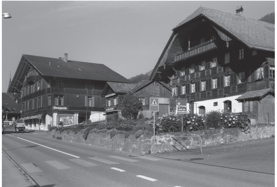
14 Hauptstrasse, östlicher Dorfeingang mit Lindemattenhaus von 1792
