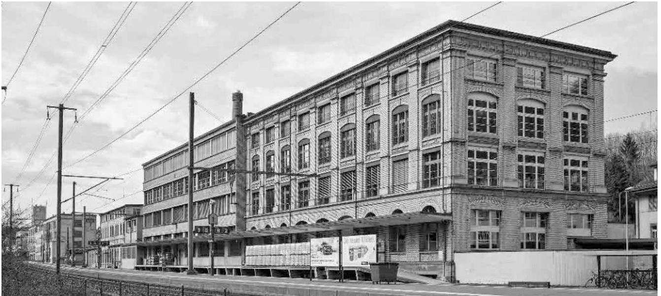
1 Ehem. Fassonierungs- und Speditionsgebäude, 1896
