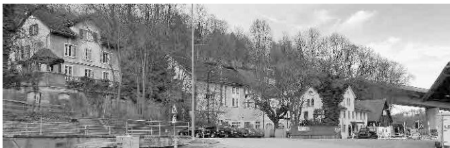
9 Angestelltenhäuser und Restaurant «Zur Hammermühle», 1843
