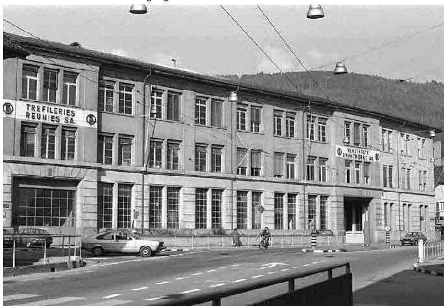
56 Hauptfront der ehem. Drahtwerke in Bözingen
