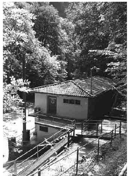
41 Pumpwerk und EW Leubringen
