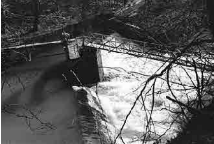
42 Schwellenwerk EW Biel
