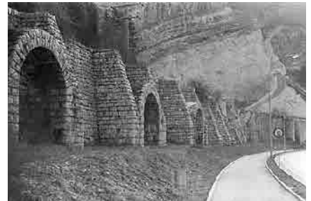
3 Schutzbauten Steinbruch Arvel
