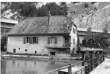
6 Altbau mit Flusswehr
