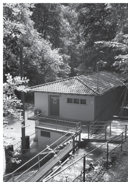
41 Station de pompage us. él. Evilard
