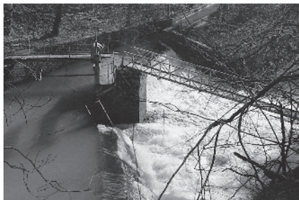
42 Retenue usine électrique Bienne
