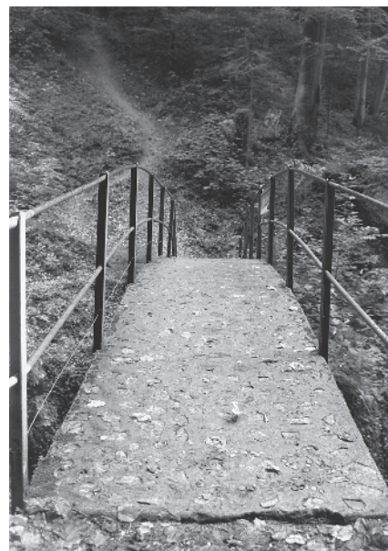
48 Passerelle en béton 1889/1932
