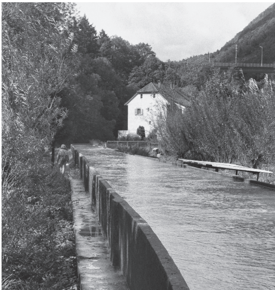
35 Canal en dessous de Frinvillier
