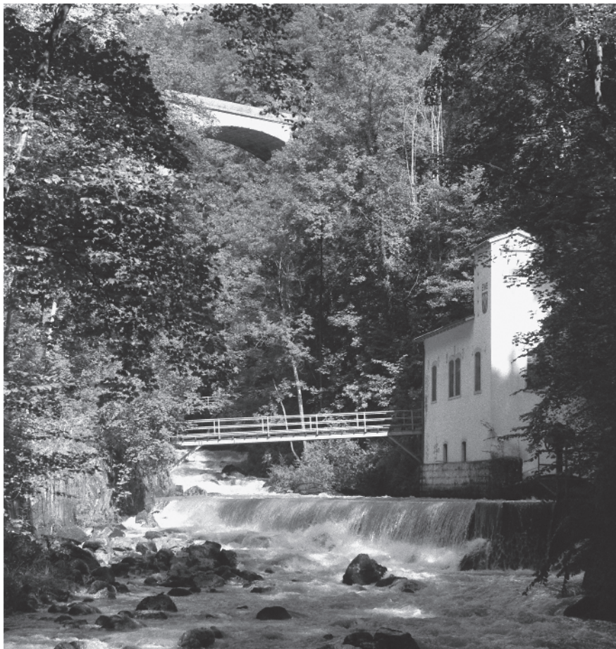
45 Usine électrique ville de Bienne
