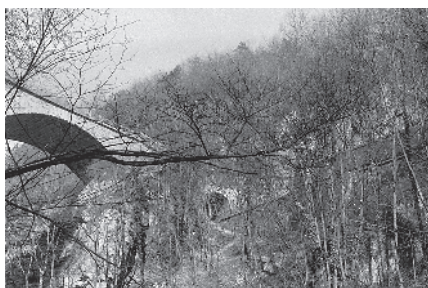
44 Pont routier de 1868
