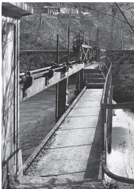
27 Retenue au dessus de Frinvillier
