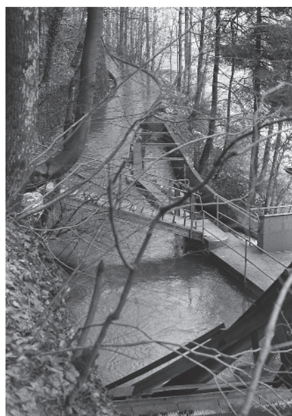
40 Canal usine électr. Evilard
