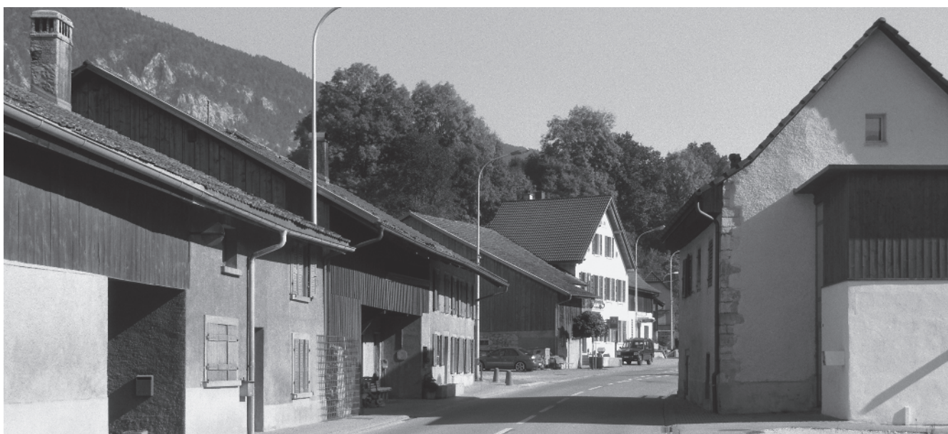
14 Grand-Rue, ancien moulin de 1750
