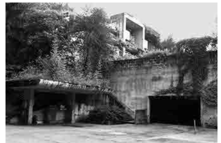
6 Tankstelle und Garageneinfahrt
