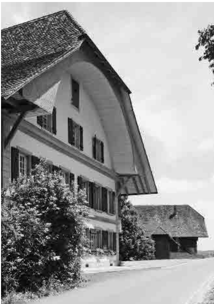
7 Wirtschaftsbauten des ehem. Instituts
