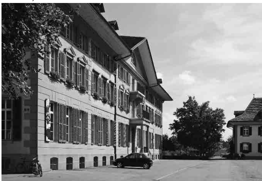
2 Grosses Haus, 1817–21, Hauptgebäude des Gymnasiums
