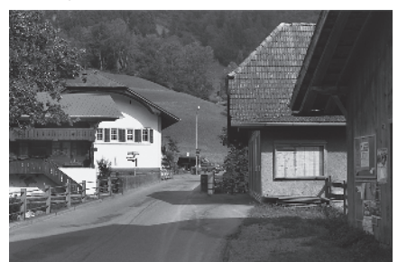
7 Brückenkopf, Betonbrücke von 1909
