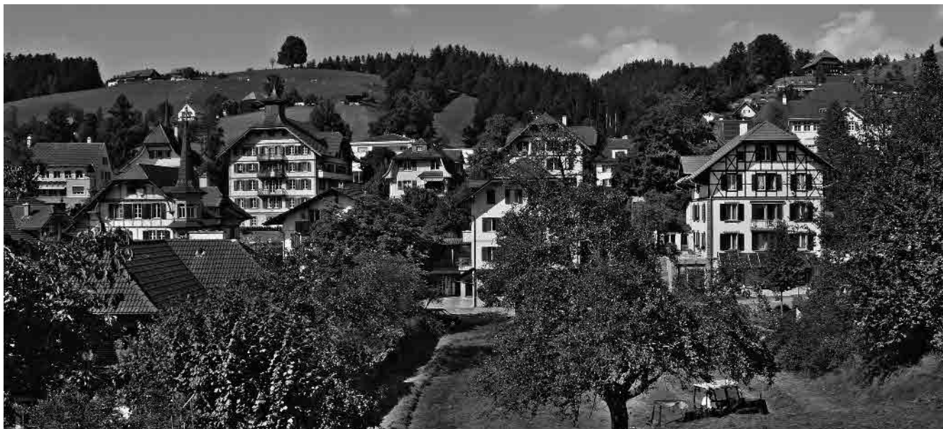
22 Allee- und Oberfeldstrasse
