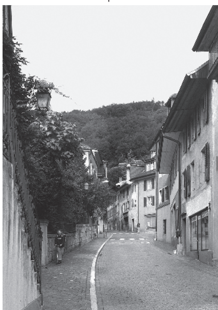
20 Route du Château
