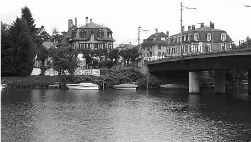
36 Kanalbrücke und Brückenkopf
